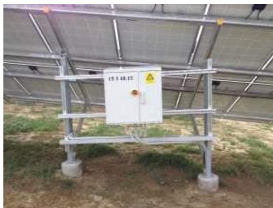
Slika 4, Slika 5: Pretvarači i SPMO ormar elektrane GR.E2
