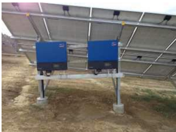
Slika 4, Slika 5: Pretvarači i SPMO ormar elektrane GR.E2
